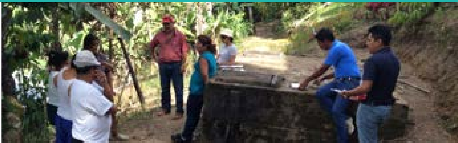
Delegación Provincial de Zamora Chinchipe durante visita in situ al barrio San José de la Ciudad de Zamora, para constatar daños en tanque de captación de agua.
